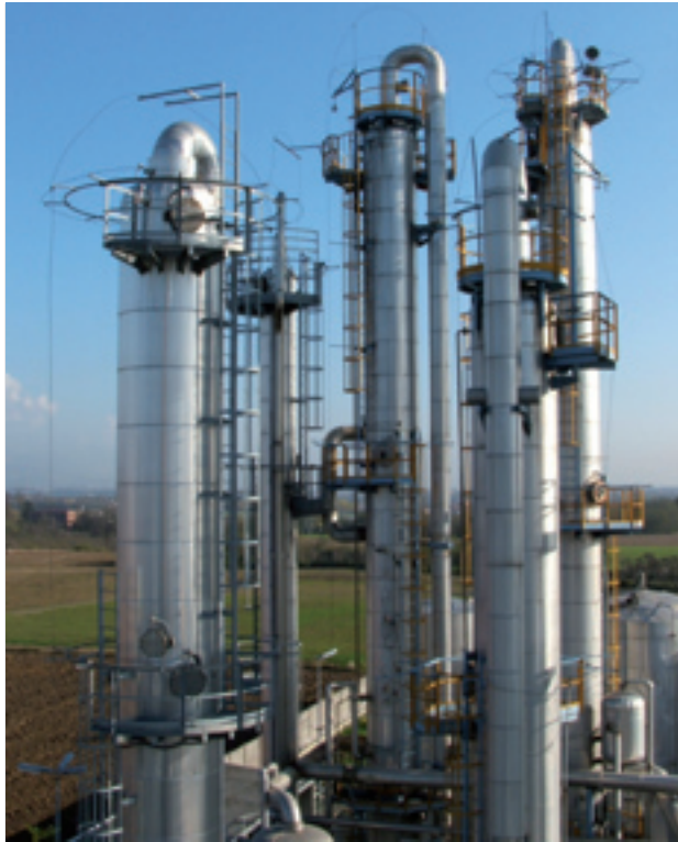
Rectifiers (distillation columns)
